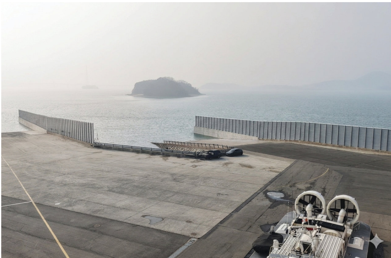
인천해양경찰청(영종도 공기부양정 기지 슬립웨이 방파벽공사)
